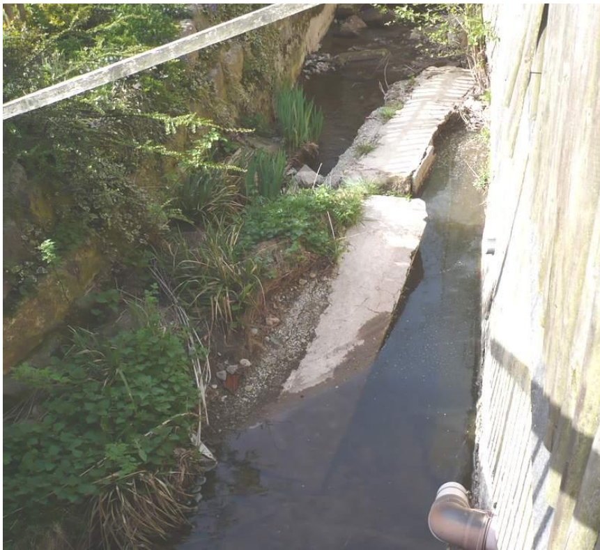
Eingefallene Stützmauer im Heschlachbach (2005), Foto Frühjahr 2011
